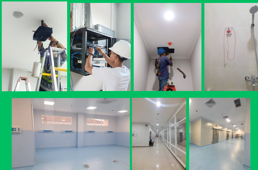
Instalasi Pekerjaan Elektronik
