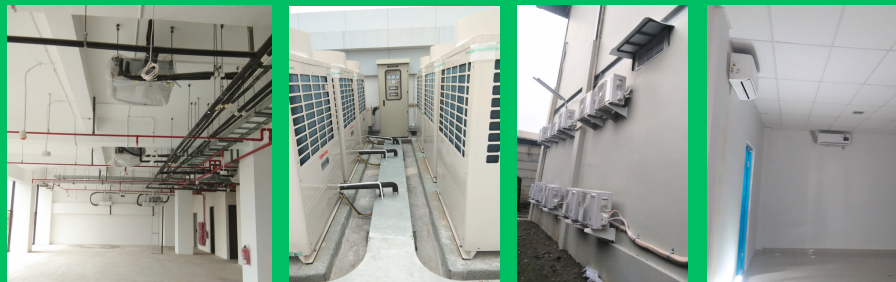
Pekerjaan Tata Udara
